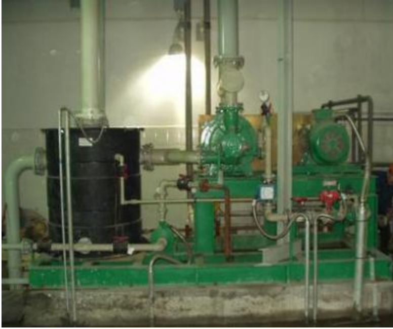
水环真空泵管路连接系统
